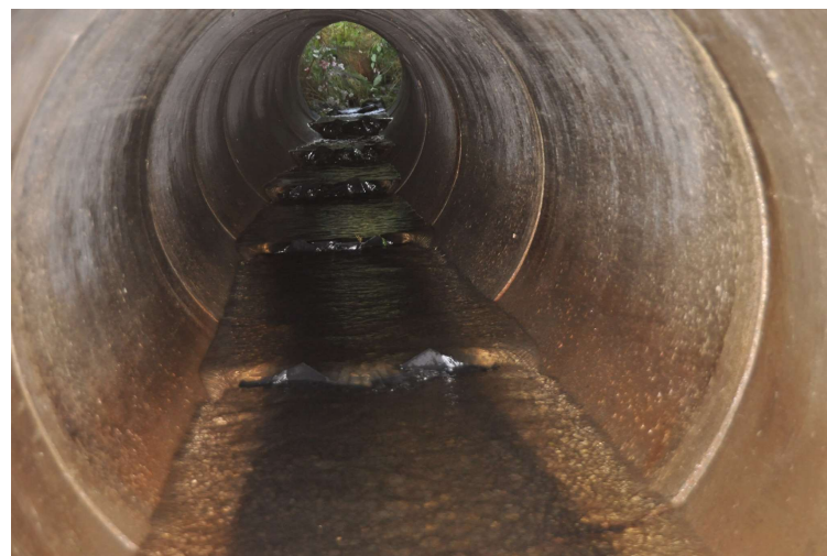
Terskler i Valbekken. Finansiering Redd Villaksen
