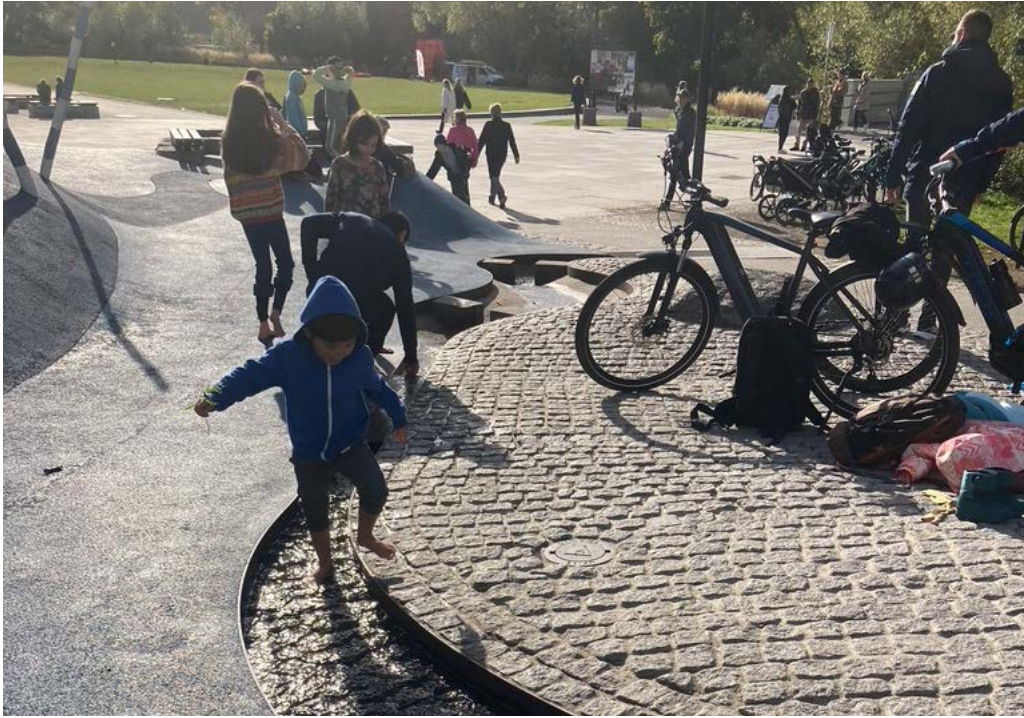
Figur 1: Overvannstiltak som lekeplass
