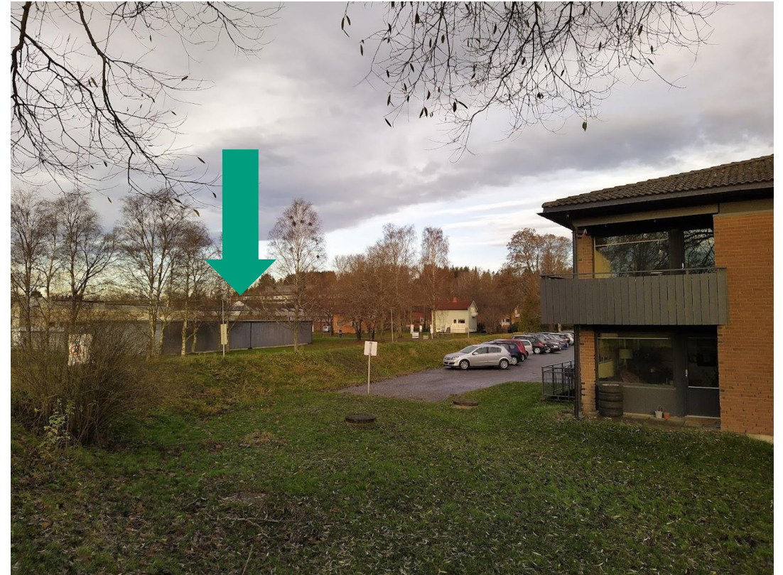
Svartvannet går i rør under veien over til REALTEK
