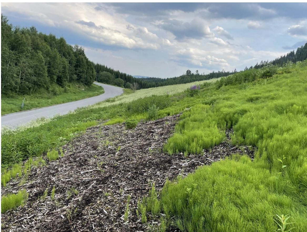
Figur 4.5: Oksidasjonsfilter på deponi i Skjørdalen
